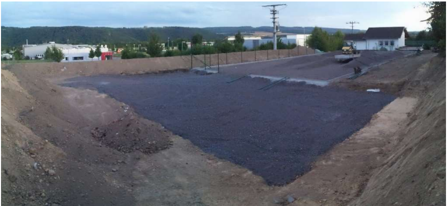
Die Vorarbeiten für Beach- und Tennisplatz sind erledigt.
