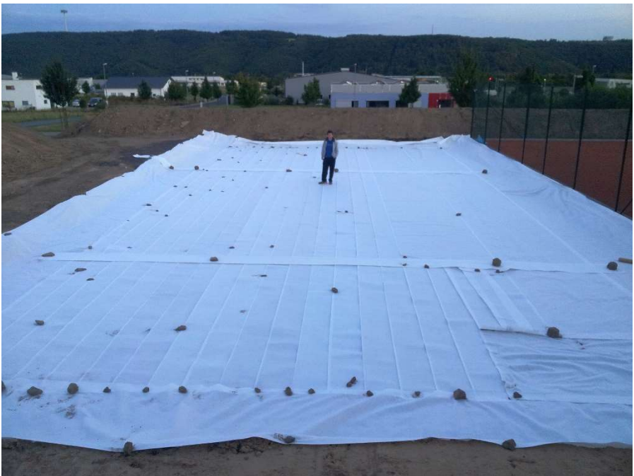
Matthias Garrn hat die Antibewuchsplane gut verlegt.
