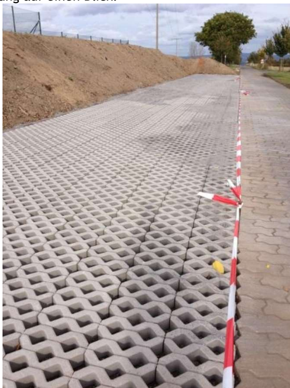
Auch die Rasengittersteine unseres neuen Parkplatzes sind verlegt.
