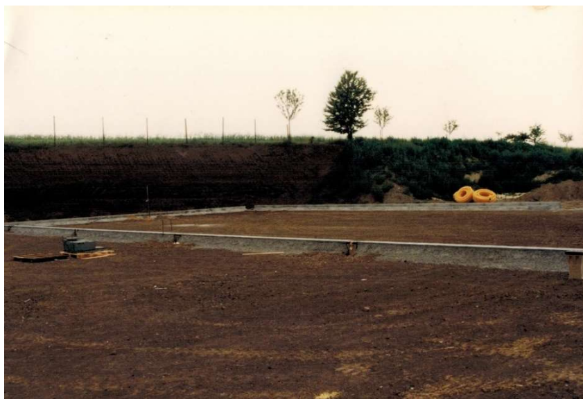
Erdarbeiten für die Tennisplätze
